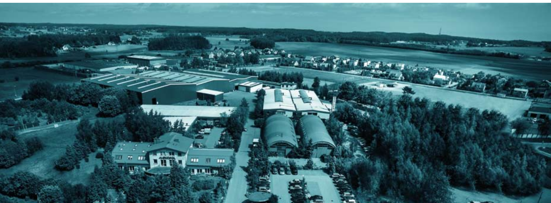
ZAPLECZE PRODUKCYJNE, LOGISTYCZNE, PAKOWNIA ORAZ SIEDZIBA FIRMY ZNAJDUJĄ SIĘ W CHWASZCZYŃNIE NA POMORZU. FOT. MARCOPOL
